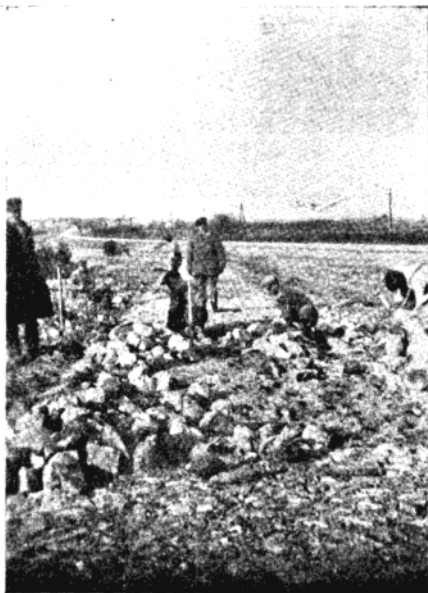
Końcowe roboty przy budowie szosy do Zalesia Górnego.
